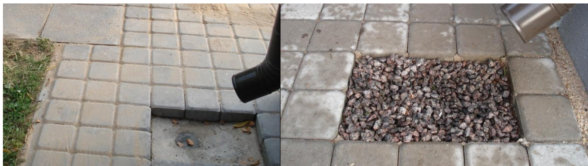
Foto 16: (vasakul): vihmavee kogumissüvendi võimalik lahendus. Põhjas on sõelaga varustatud vee äravooluava.
