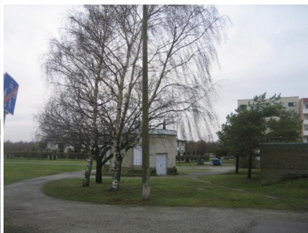
Foto 6: Papiniid 33b pumpla vaadatuna Papiniidu 33 kinnistult (foto: Piret Unn).
