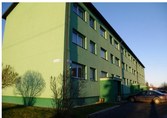
Foto 3: Puistuksi tee 12 korterelamu, näha on istutatud põõsad ja maja ees olev asfalttee ning parkimisala (Foto: K. Karjus).
