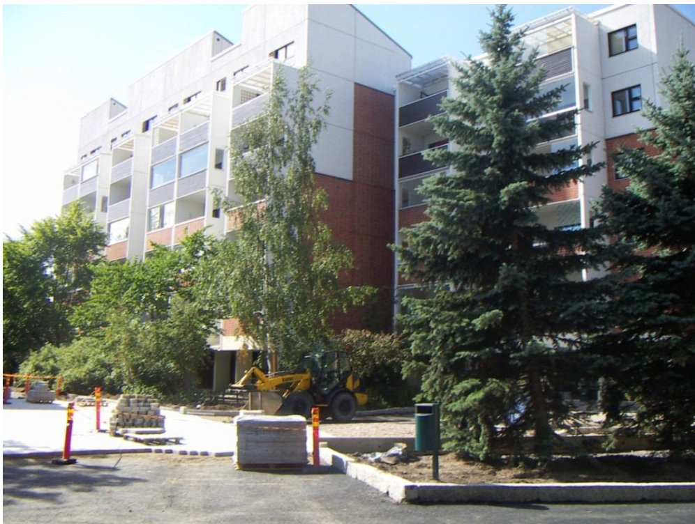
Foto 6: Espoo kogemused. Sademevett läbilaskvate vuugitud kiviluutiste ehitustööd. Ehitustegevuse käigus säilitatavad igihaljad puud on taotluseks haljastuses kulusid kokku hoida. ( http://commons.wikimedia.org/wiki/File:Kirkkoj%C3%A4rvi_Espoo_Finland.JPG , 27.02.2014)
