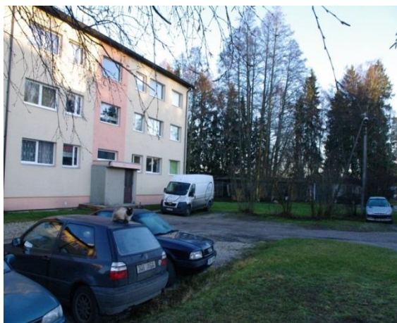
Foto 7: Puistuksi tee 16 korterelamu eestvaade, näha on hoone ees olev parkla, hoone esine ja taamal kuusehekk (foto: P. Unn)
