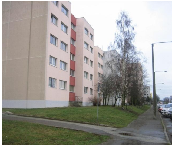
Foto 26: Papiniidu 27 kinnistu vaadatuna hoovi poolt (foto: Piret Unn)
