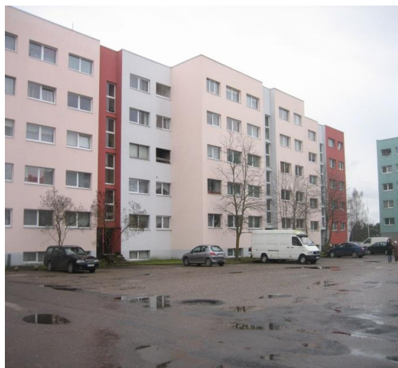
Foto 27: Papiniidu 27 kinnistu, vaadatuna hoovi poolt (foto: Piret Unn).
